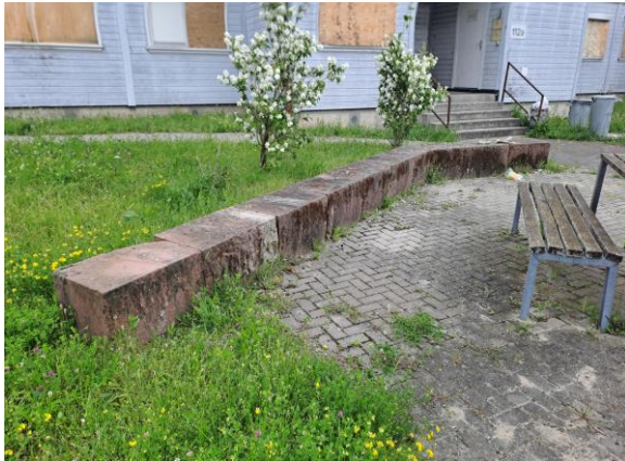
Abbildung 4: Sandsteinmauer im Hof (Zwischen den Wohngebäuden).
