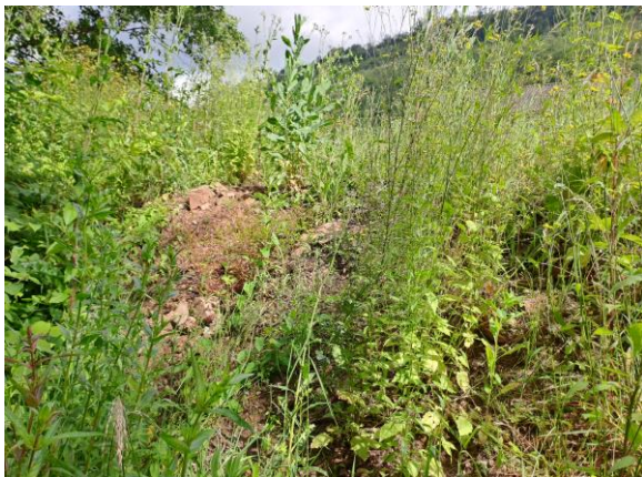
Abbildung 2: Böschungsbereich der Aufschüttung.
