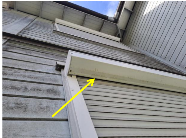
Abbildung 5: Rolladenkasten. Spalte an der Unterseite ermöglicht das Einschlüpfen in den Hohlraum der Kästen.
